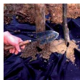
4. Epandre du sable
