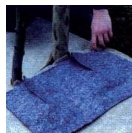
4. Prévoir un recouvrement
